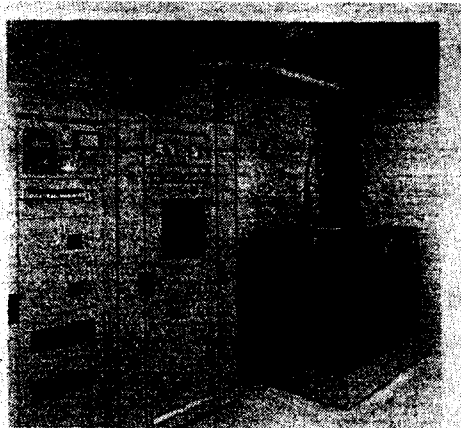
transformateur de 2 000 kVA, 20 kV / 410 V.
