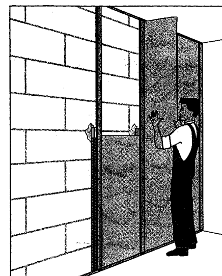
Mise en place de la laine minérale.
