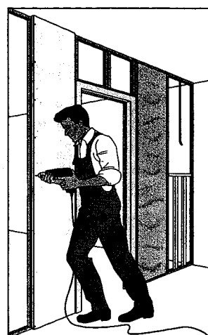
Vissage des plaques du 1er parement.
