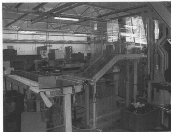
"MULTIJOB": zone de tri automatique et d'évacuation
