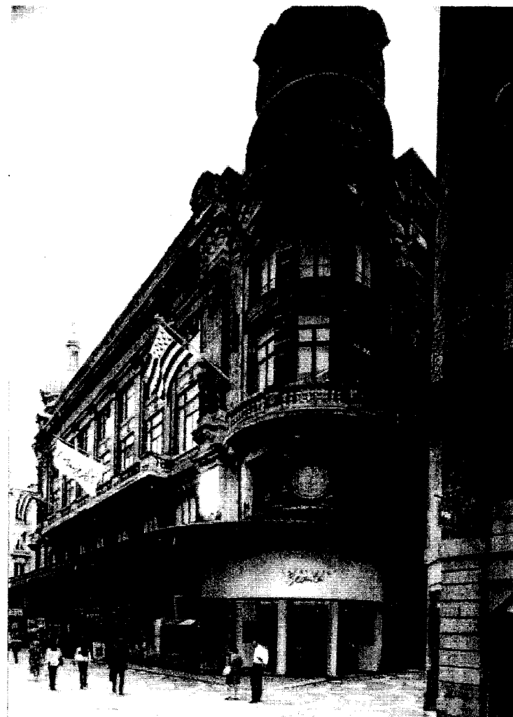
Angle Sainte CATHERINE/ Rue Saint-Jacques Etat du patrimoine
