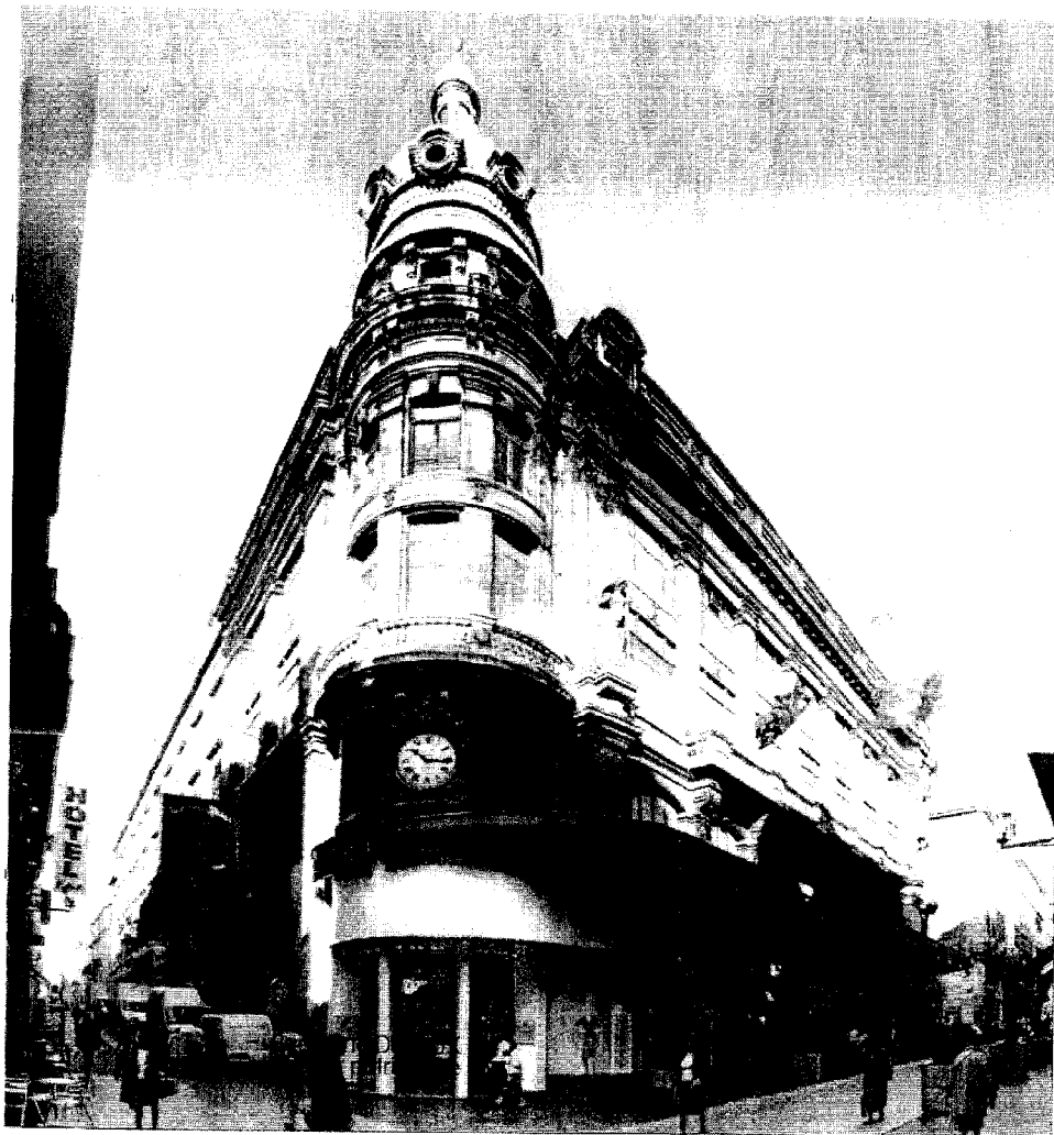
Angle Porte DIEAUX/Sainte CATHERINE Etat du patrimoine
