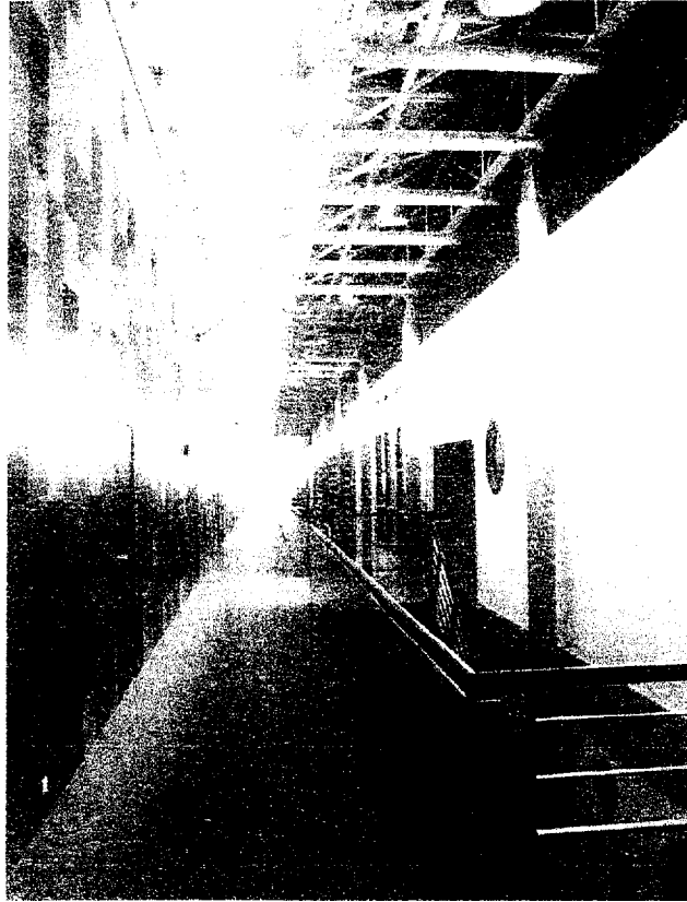
Vue de la coursive : nappe 3D, butons en V
