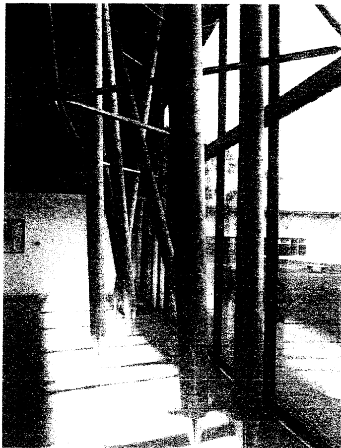
Vue du hall : poteaux mikados
