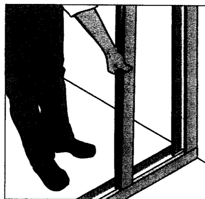
Les montants, coupés à hauteur, sont emboîtés dans les rails.
