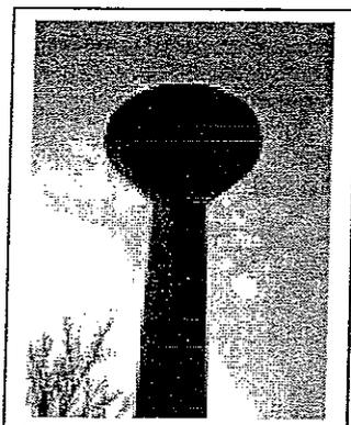
Le château d'eau de Soulosse en plaine est constitué d'un cylindre et d'un tronc de cône (voir schéma ci-dessous).
