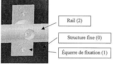
Le rail est maintenu à chaque extrémité sur la structure fixe grâce à deux équerres vissées sur celle-ci. La fixation du rail étant réalisée par vissage de celui-ci dans les équerres.
