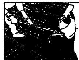
3- Mise en oeuvre du glacis de bitume (surfaçage)
