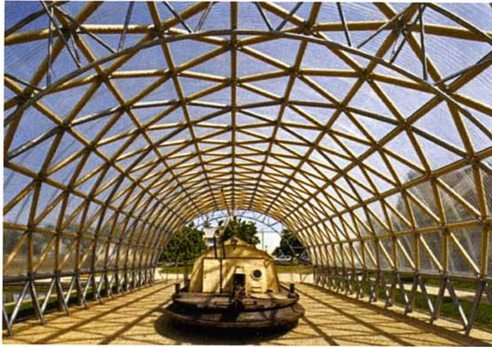
Structure associant métal, polycarbonate et tubes de carton recyclé. Halle du bateau Toueur à Pouilly-en-Auxois (21), Shigeru Ban.
