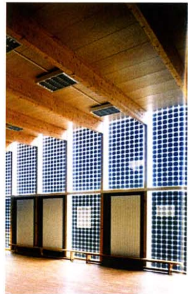
Des vitrages avec incorporation de cellules photovoltaïques. École à Morschwiller (68) TOA architectes.
