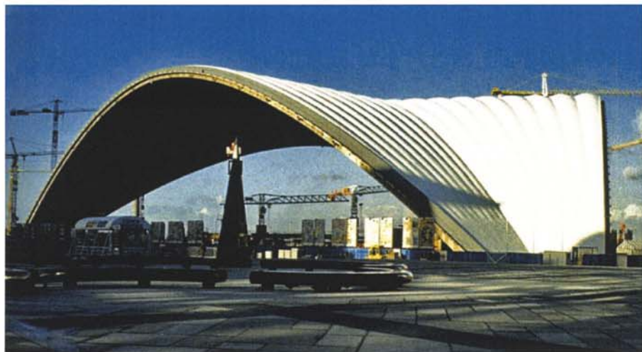
La coque en béton du CNIT lors de sa rénovation, CNIT, Paris-La Défense , Bernard Zehrffuss.
