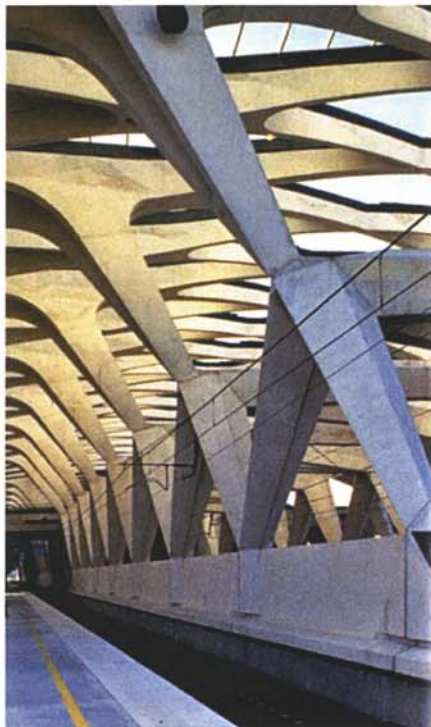
Structure béton, Gare TGV à Satolas (69) , Santiago Calatrava.
