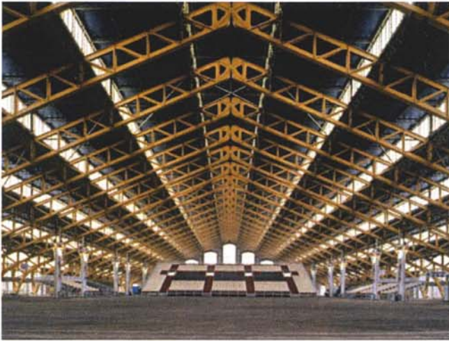
Structure métallique, Halle Tony Garnier (1928, rénovation en 1989 par Reichen et Robert), Lyon.
