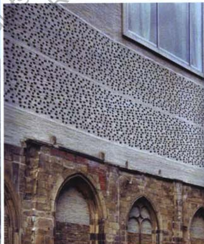
Détail de la façade
