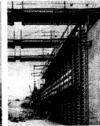
Exemple de solution de coffrage économique. Coffrage de tunnel avec GT 24
