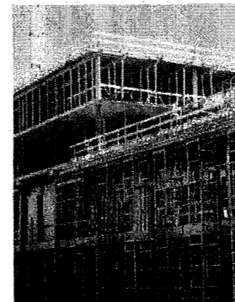
Utilisation de poutrelles GT 24 avec MULTIFLEX sur tours gerables ST 100 ou tables de coffrage UNIPORTAL.
