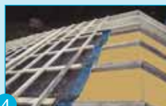
4 Pose des contre-liteaux et des liteaux.
