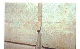
**Rejointoiement** : reconstituer les joints entre les pierres (identifier auparavant la nature du joint en place : plâtre, ciment, chaux).
