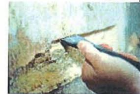
**Réparation en partie courante** : réparer les dégradations situées sur les parties planes et verticales de la façade.
