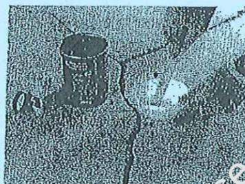
Mélanger la résine et le durcisseur suivant la notice du fabricant.
