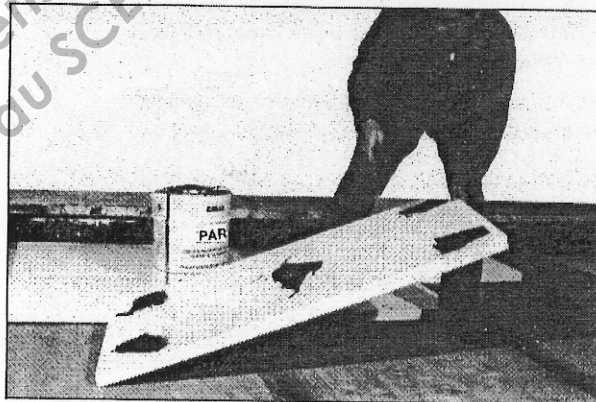
Soudure de l'écran pare-vapeur
