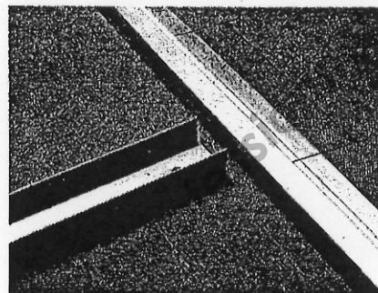
Fixer les rails hauts et bas tous les 0,60 m maximum avec des fixations appropriées.
