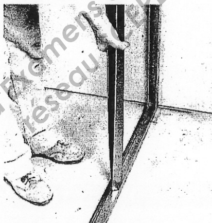
Les montants, coupés à hauteur, sont emboîtés dans les rails.
