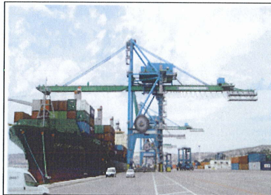
Portique et bateau au déchargement
