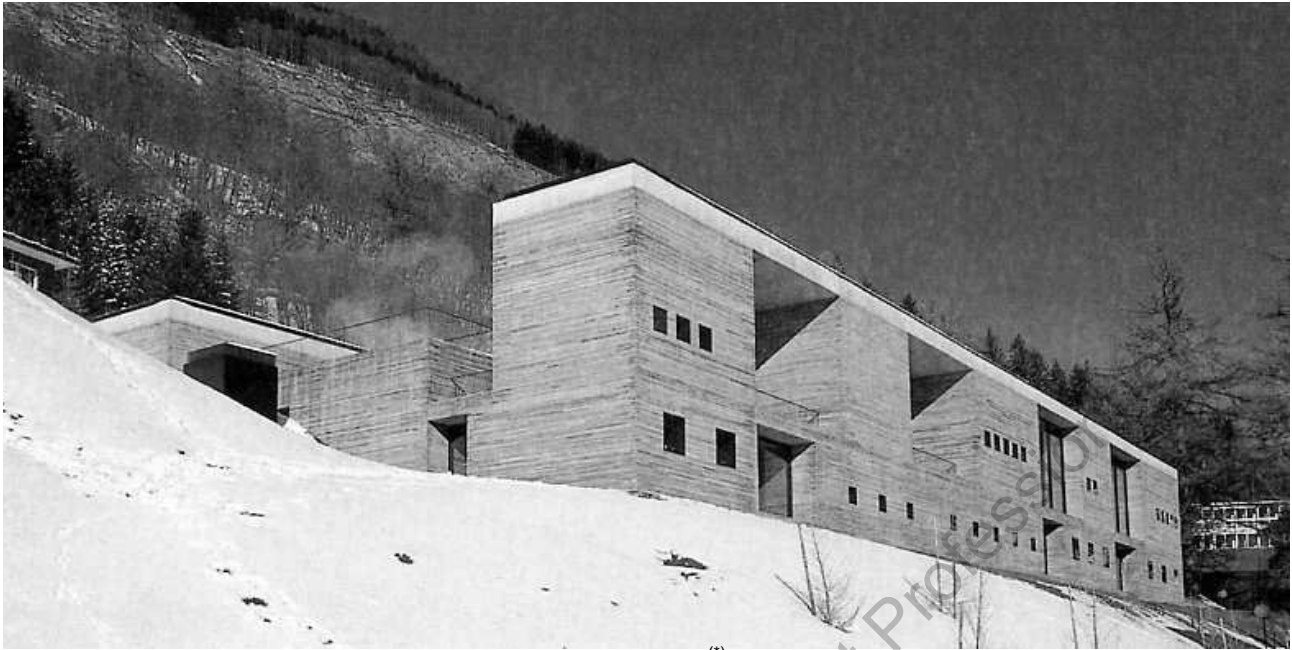
Façade Est / Murs en gneiss (*) , couverture en béton armé
