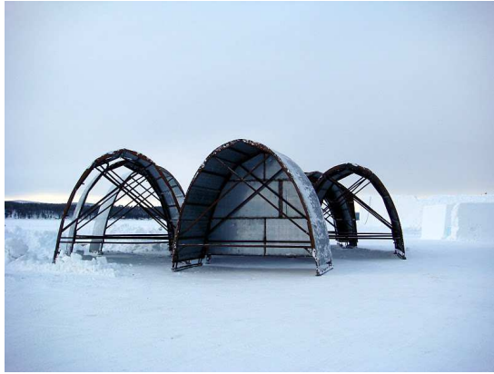
Moules utilisés pour la construction des voûtes
