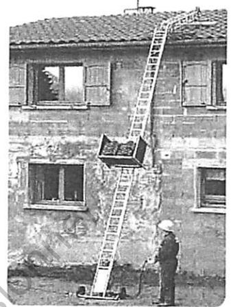
Le chariot du monte tuiles et la charge hissée ont une masse globale  $m$  égale à  $100 \text{ kg}$ . Cet ensemble est schématisé ci-dessous par un solide parallélépipédique de centre d'inertie  $G$ . Le câble de traction, tracté par un moteur électrique, est accroché en  $A$ .
