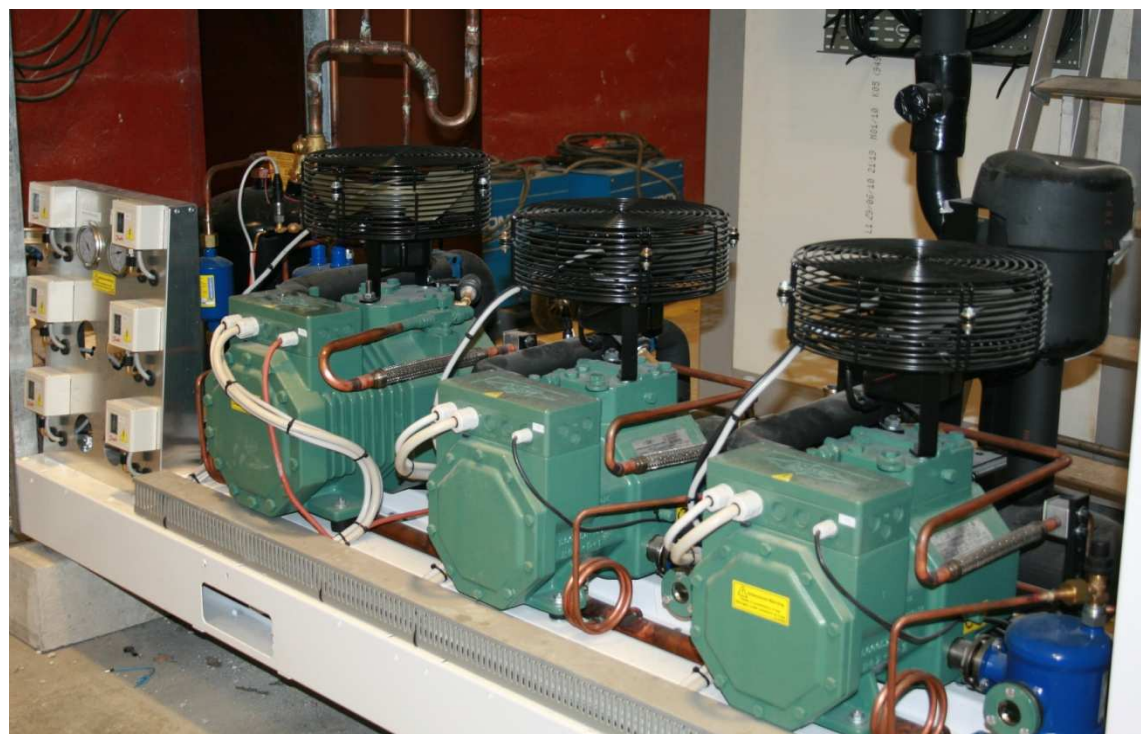
Cette centrale frigorifique à 3 compresseurs permet de maintenir une chambre froide à une température inférieure de - 18°C.
