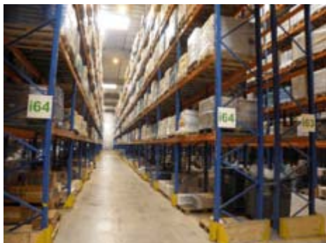
Palettiers de stockage à l'entrepôt Leroy Merlin à Dourges.
