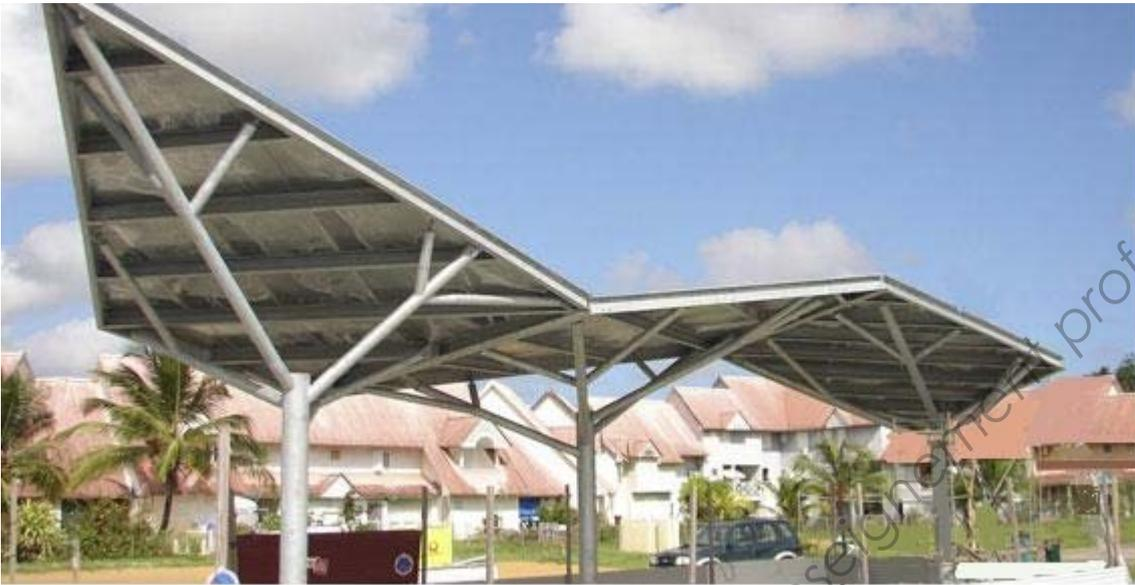
Cet auvent se compose de 3 versants soutenus par trois poteaux et leurs bracons. Les versants **ABCD** et **EFGH** sont des plans **de bout**, leurs surfaces sont identiques. Seul le poteau vertical **IK** et 3 de ses bracons **IA – IJ – IB** seront représentés. Les points **B** et **H** sont dans le plan frontal. Le point **K** est dans le plan horizontal. Le point **J** appartient à la droite **AD**
