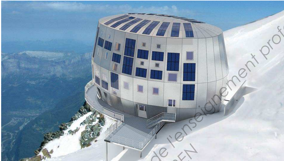
Nouveau refuge du Goûter – http://www.refugedugouter.fr/ .
