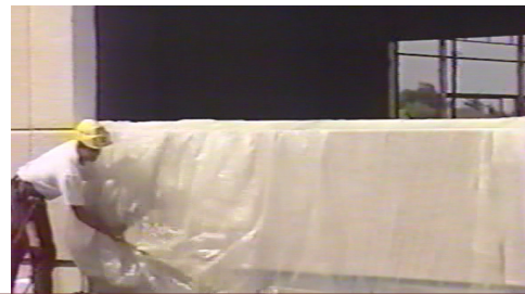
13 Mise en place des bâches de protection
