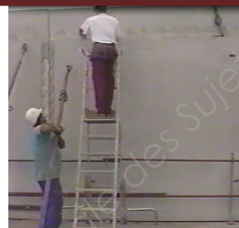
13 Mise en place des bâches de protection
