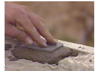
Mise en place des cales (niveau)
