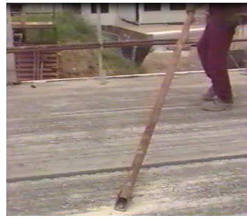
Fixation des tirants-poussants sur le plancher
