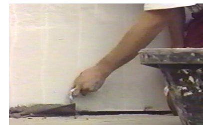
Remplissage du joint
