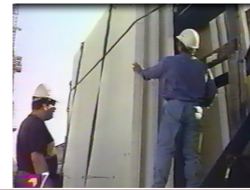
5 Vérification des panneaux avant pose
