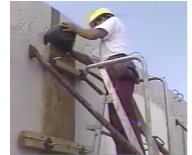
Clavetage des panneaux
