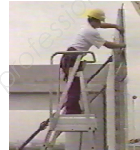
Mise en place des joints verticaux
