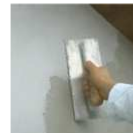
Mise en œuvre de l'enduit phase 1.
