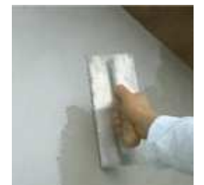
Mise en œuvre de l'enduit phase 2.
