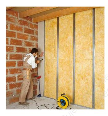
**Important :** le vissage du deuxième parement à joints décalés par rapport au premier parement.
