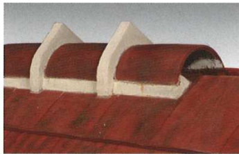
Faitage scellé avec faitières 1/2 rondes sans emboîtement. Crêtes et embarures réalisées au mortier (D.T.U. 40.23. art 3.4).
