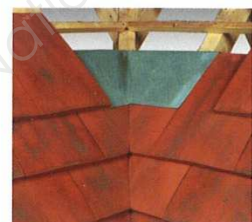
Noue à tranchis avec noquets métalliques cachés.
