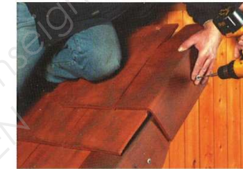
Mise en œuvre des rives individuelles gauches et droites, posées un rang sur deux et fixées par vis et rondelles d'étanchéité.
