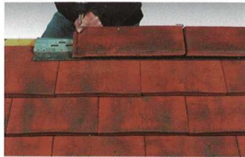
Après mise en place du closoir ventilé, les faitières sont vissées dans la lisse de rehausse.
