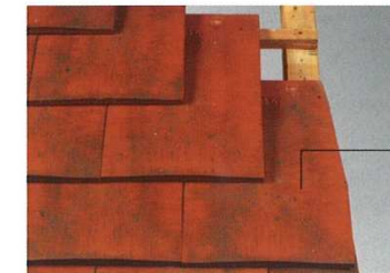
Mise en œuvre des tuiles d'approche en rive, posées un rang sur deux. Ces tuiles sont à découper suivant dimensions définies sur coupe transversale
