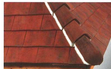
Arêtier scellé avec arêtiers et about d'arêtier angulaire petit modèle sans emboîtement.
