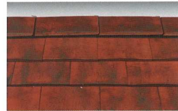
Faitage réalisé à sec avec faitières / arêtiers angulaires à emboîtement et closoir ventilé, sans emploi de mortier.
