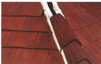
Après coupe des tuiles d'approche, mise en œuvre des arêtiers angulaires petit modèle sans emboîtement, utilisation de mortier (D.T.U. 40.23. art 3.4).
