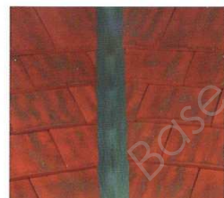
2. Les tuiles sont tranchées biaises, parallèlement à l'axe de la noue.
