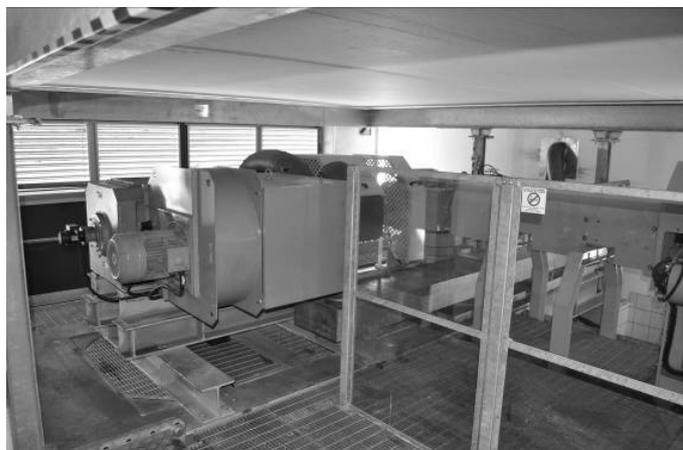
Pour la marche dégradée en mode secours, l'entraînement est assuré par deux moteurs asynchrones d'une puissance de 75 kW chacun, alimentés par un groupe électrogène.
