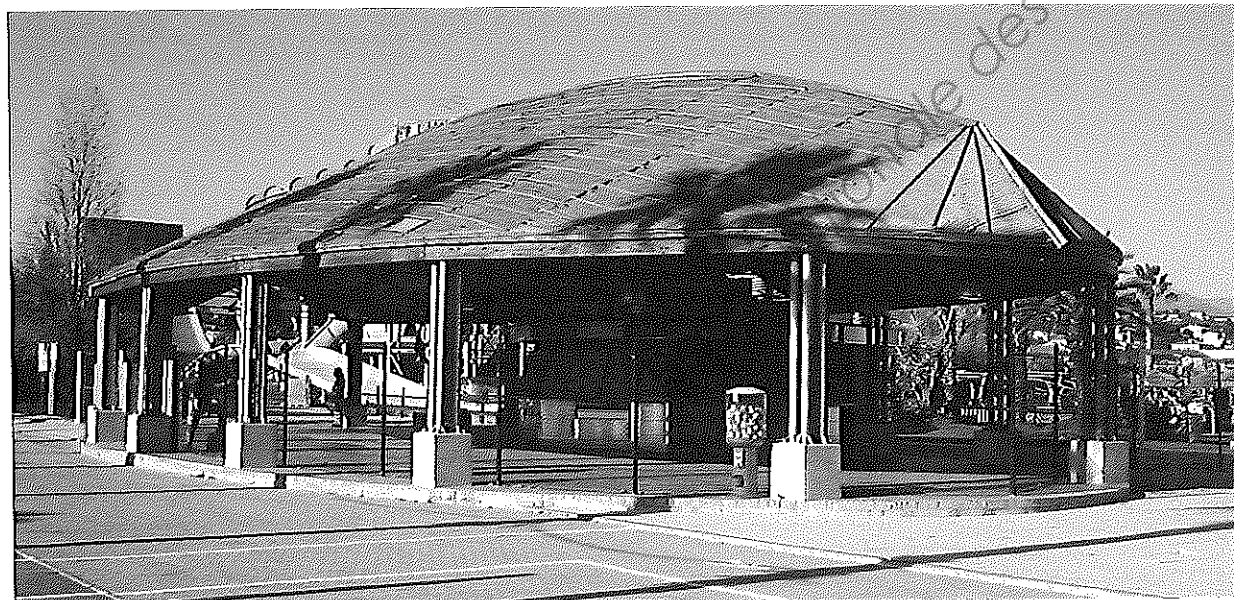
Vue extérieure de la terrasse une fois réalisée.
