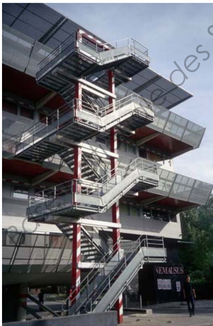
Escalier conduisant aux coursives qui desservent les appartements
