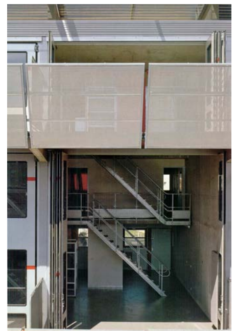
Vue sur le séjour d'un triplex depuis la terrasse
