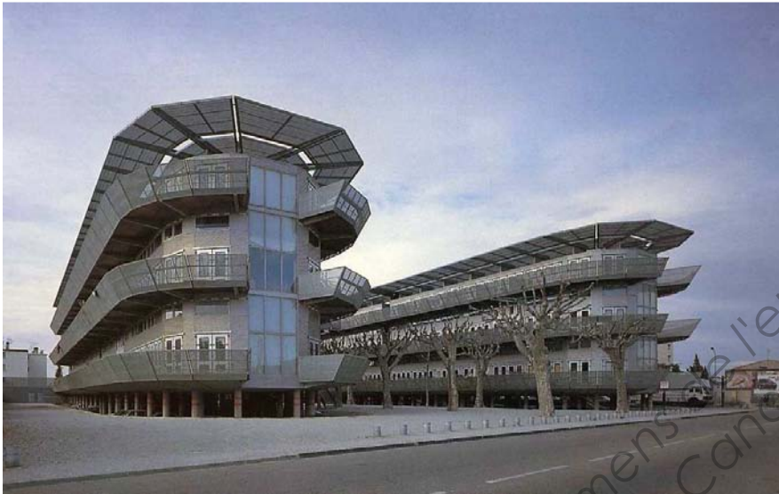
Vue générale sur les deux bâtiments
