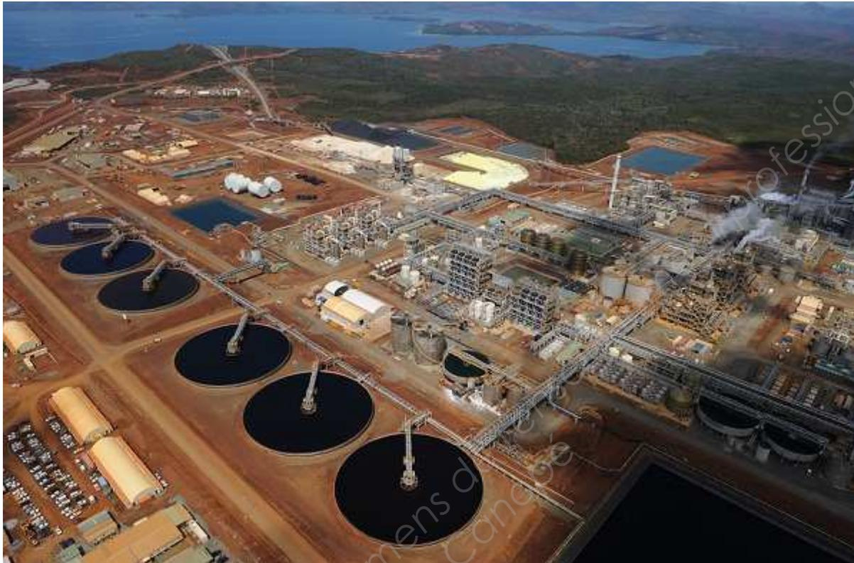
Le procédé consiste essentiellement à faire subir différents traitements au minerai réduit en pulpe par l'ajout d'eau, en utilisant une solution d'acide pour en extraire du nickel, transformé en oxyde de nickel et du cobalt, transformé en carbonate de cobalt.
