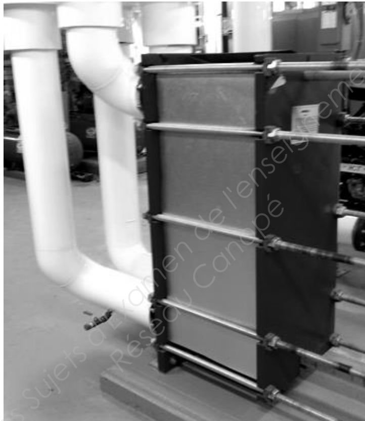
Photo de l'échangeur à plaques
