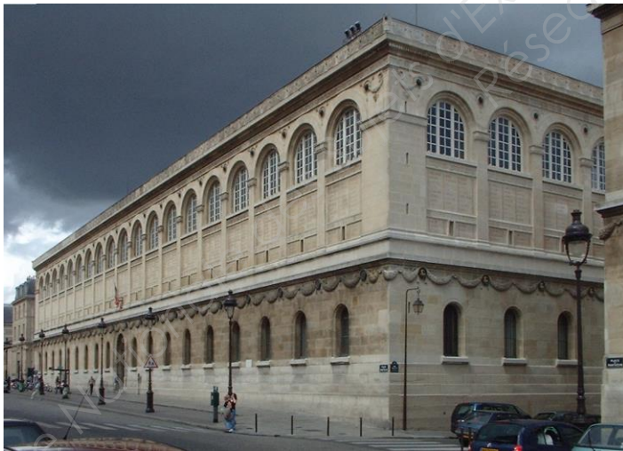
Vue extérieure du bâtiment Salles de stockage des livres au premier niveau et salle de lecture au second
