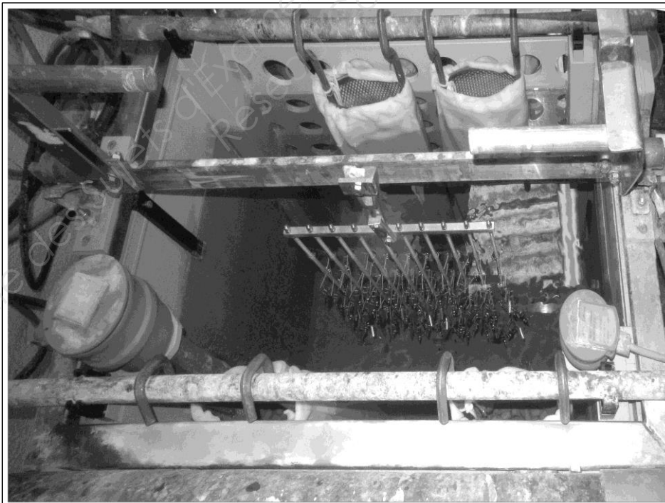
Photo de la cuve de cuivrage
