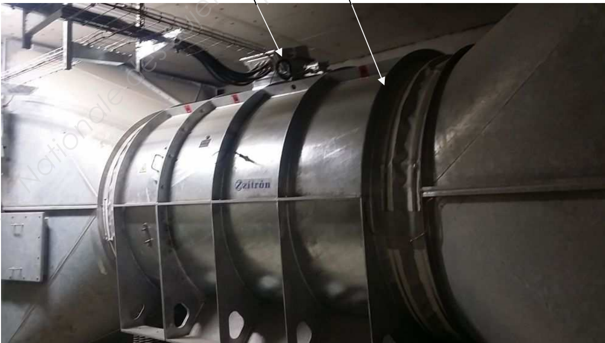
Figure 4 : présentation d'un groupe motoventilateur
