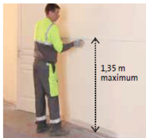
Figure 1 : pose des lisses Clip'Optima et de la fourrure murale Optima.
