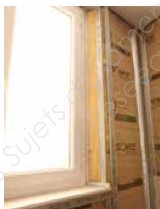
8 VUE DE L'OSSATURE DE TABLEAU
