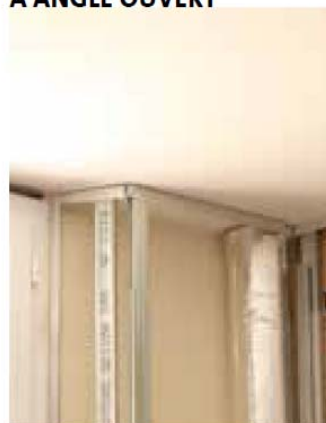
4 SEGMENTS DE LISSES CLIP'OPTIMA FIXÉS À ANGLE OUVERT
