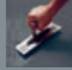
2<sup>e</sup> passe : après séchage avancé ou complet, appliquez l'enduit au rouleau puis ratissez à la lisseuse. Ferrez pour révéler le décor créé.
