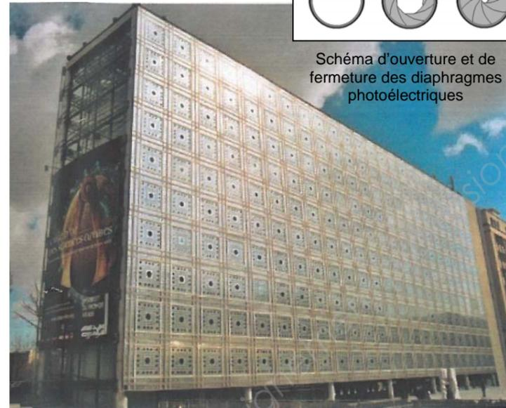
Schéma d'ouverture et de fermeture des diaphragmes photoélectriques
