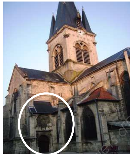
Portail sud du transept - Etat initial-
