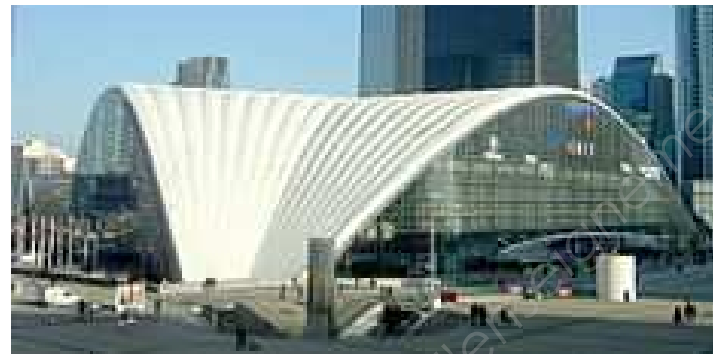
La coque en béton du CNIT lors de sa rénovation. Paris-La Défense, BERNARD ZEHRFUSS.
