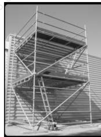
Plancher sur échafaudage fixe
