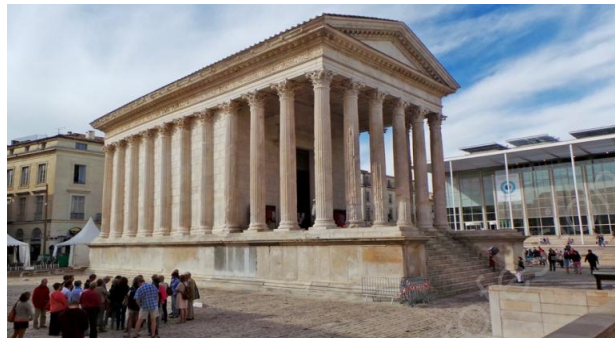
Vue du vis-à-vis entre les deux bâtiments
