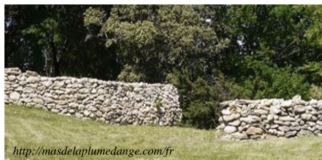
Mur de clôture
