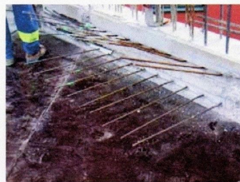
Fig. 10 Dépliement des aciers après mise en place des coffrages
