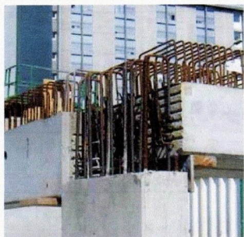
Fig. 7 Nœud poteaux poutre
