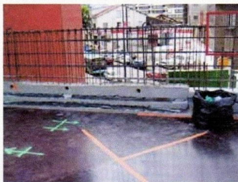
Fig. 9 Aciers en attente avant dépliement
