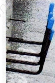
Fig. 13 Aciers poutre BA préfabriquée - KP1
