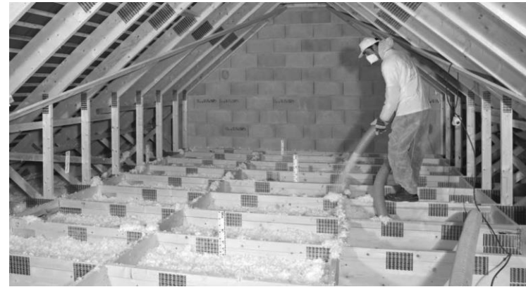
Plafond et isolation des combles
