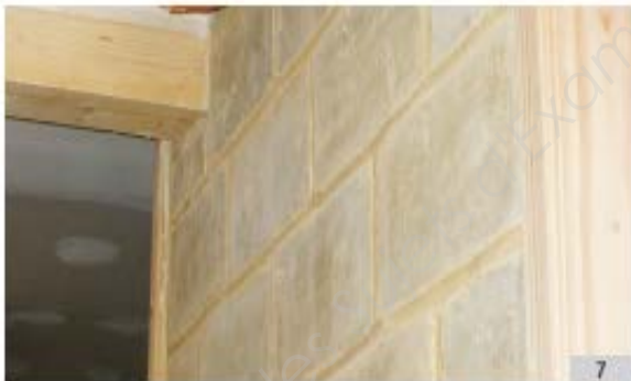
Mur en briques de terre crue
