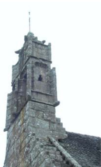
Face latérale Sud du clocher
