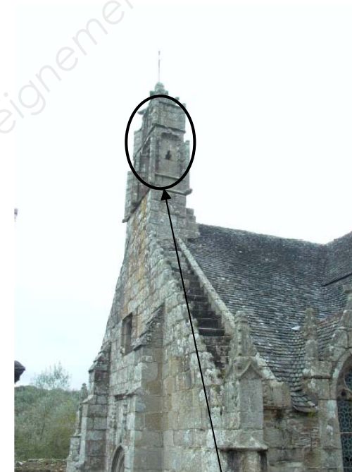
Détail du clocher au sommet de la façade occidentale
