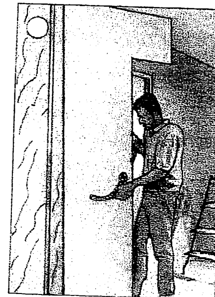
Pose de l'isolant et passage des gaines avant la pose du 2 ème parement.
