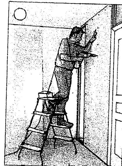
Pose de la 1 ère plaque du 1 er parement.
