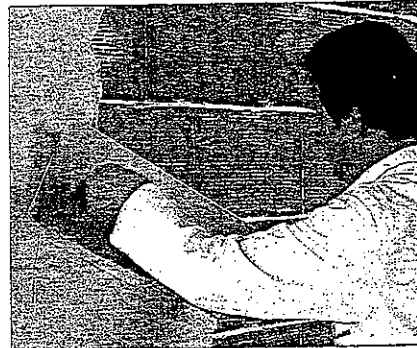
Talochage d'un plâtre manuel allégé.
